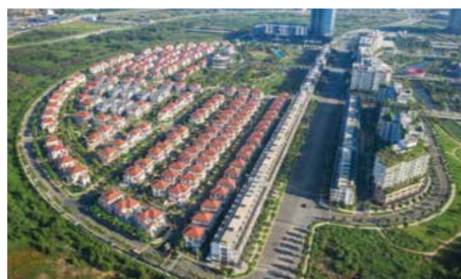
Khu đô thị Sala Số 10 Mai Chí Thọ, KĐT mới Thủ Thiêm, Thủ Đức, TP. HCM
