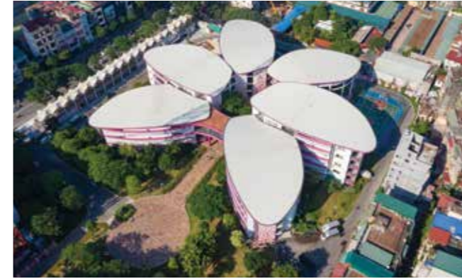
Trường liên cấp TH School số 4-6 phố Chùa Bộc, Đống Đa, TP. Hà Nội
