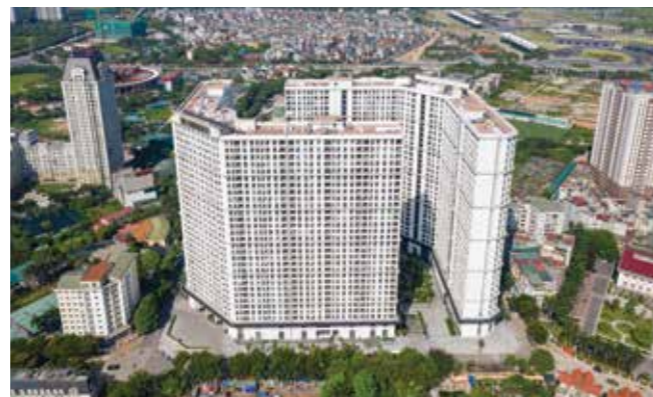
Chung cư Emerald Đình Thôn, Mỹ Đình, Nam Từ Liêm, TP. Hà Nội
